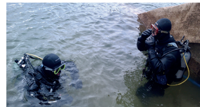
Instalación de sensores bajo el agua en la Presa de Mavrovo
